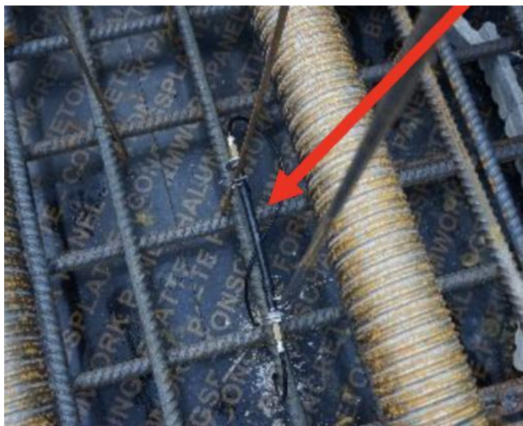
3.11-сурет – Concrete embedded FBG сенсоры практика кезіндегі сурет
